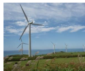
苫前風力発電所 (北海道苫前町)
