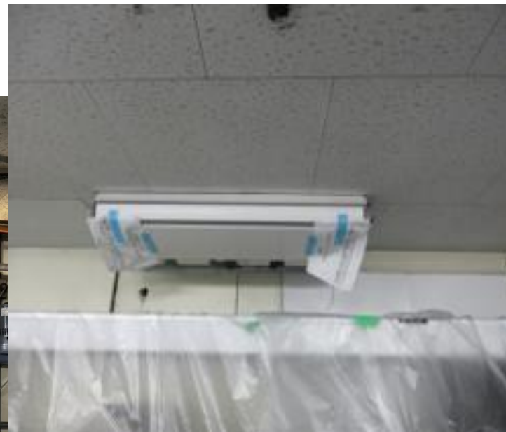
空調機の更新と 室内外機の清掃
