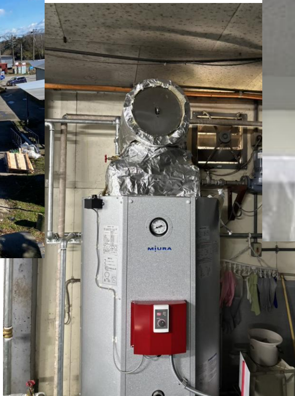
ボイラーの防断熱
